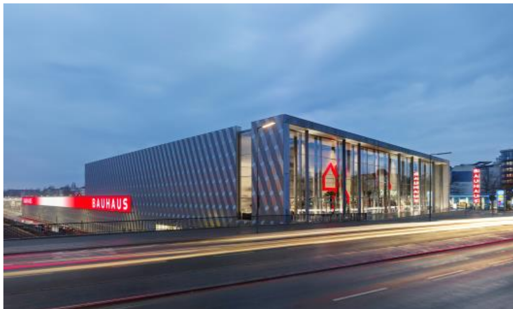
Abb. 5: Konvex und Konkav: Das Bauhaus Fachzentrum in Berlin glänzt mit einer Fassade, die aus dreidimensional gefalteten Aluminiumpaneelen besteht. (Foto: ALUCOBOND®, © Stefan Müller)
